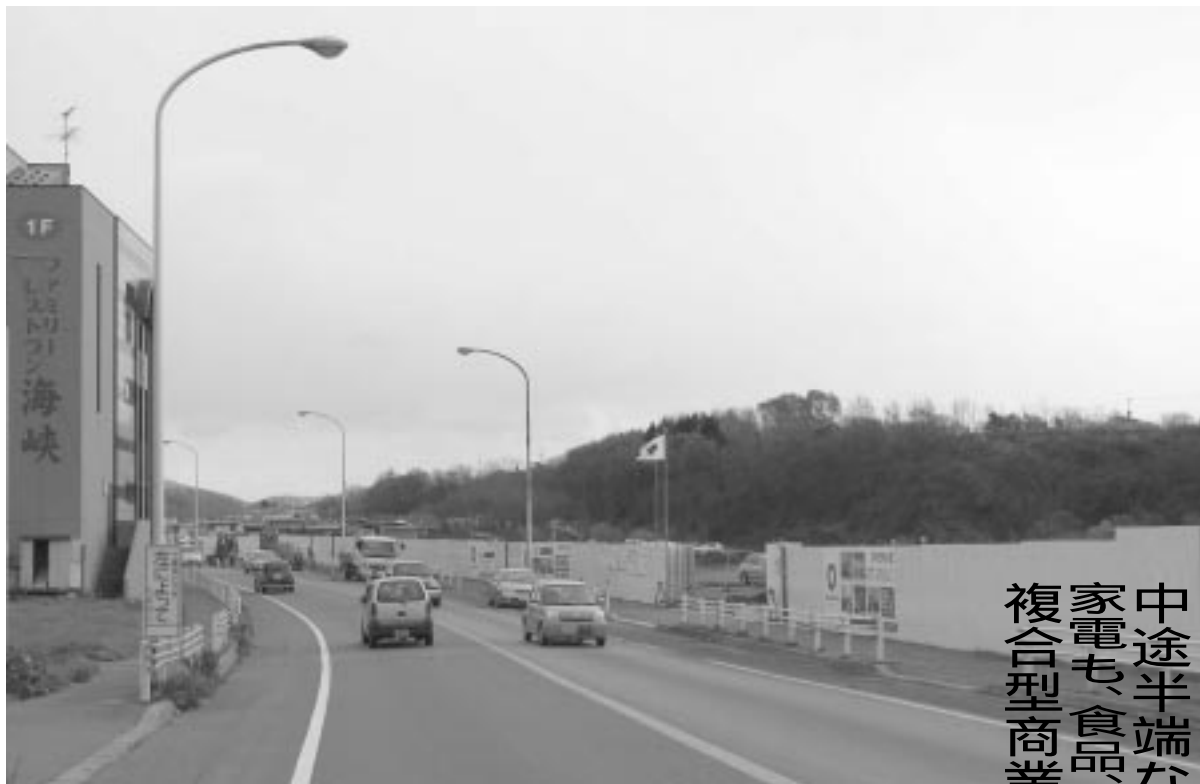
建設工事が本格化している函館市戸倉町・道道線沿いの大型複合商業施設「フレスポ函館戸倉」
